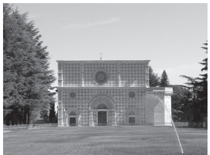
写真5 アブルツォ・ゴシック様式で有名な、Santa Maria di Collemaggio。正面は修復されているが、内部の損傷は激しく、封鎖されたまま。裏側へ回ると、外壁の修復工事中であった。
